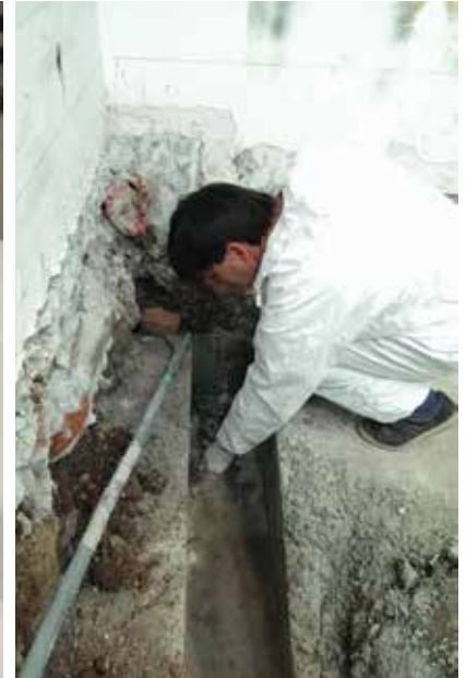
Zaustavljanje prodora vode injektiranjem kod teško dostupnih pozicija.
